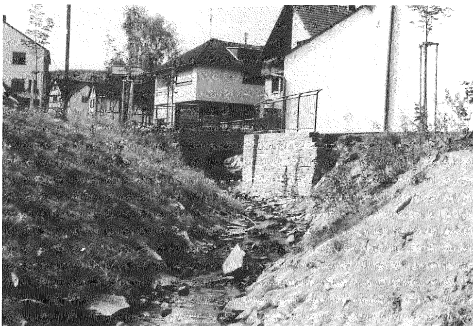
Abb. 3: Blick auf den Schalkenbach nach Fertigstellung
