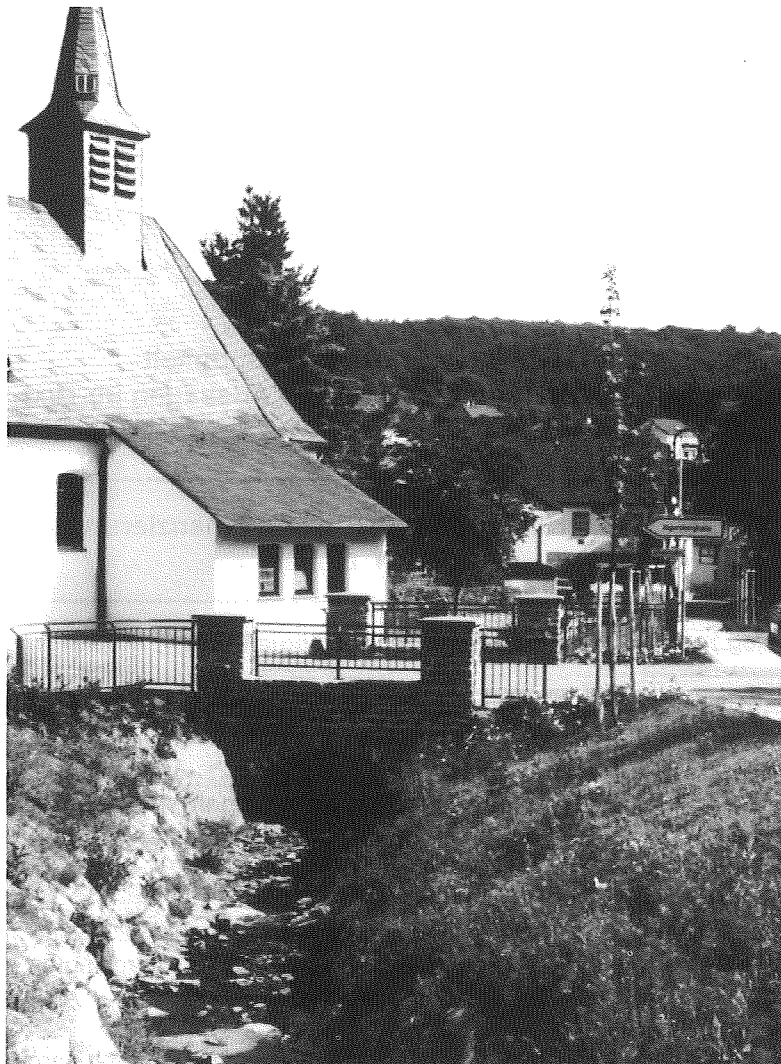
Abb. 5: Der Schalkenbach nach Fertigstellung, im Hintergrund die Dorfkapelle
